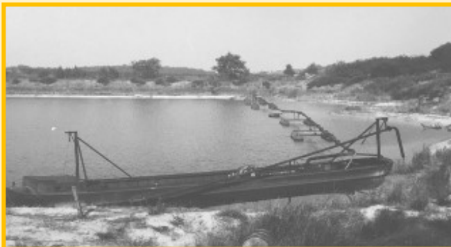
Hennie zag de zandwinning veranderen. Kiepkar en schep weken voor zandzuiginstallaties en een asfaltfabriekje op een dam in het Zandgat.
