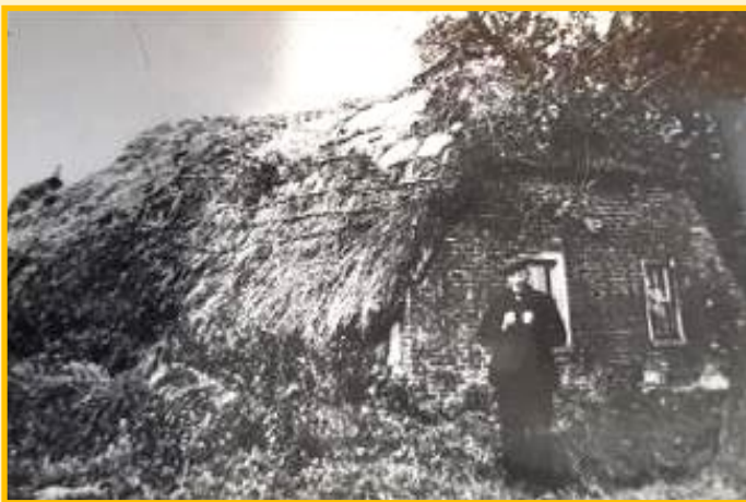
Hennie weet nog van enkele plaggenhutten in Kostvliet. In deze stulp woonde Hans Pietereulie (Klaassens). Alleen de gevel is met baksteen opgemetseld.
